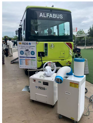
EV バス（L6）から急速充電器 Pocha+を経由しスポットクーラーへ給電中の様子
